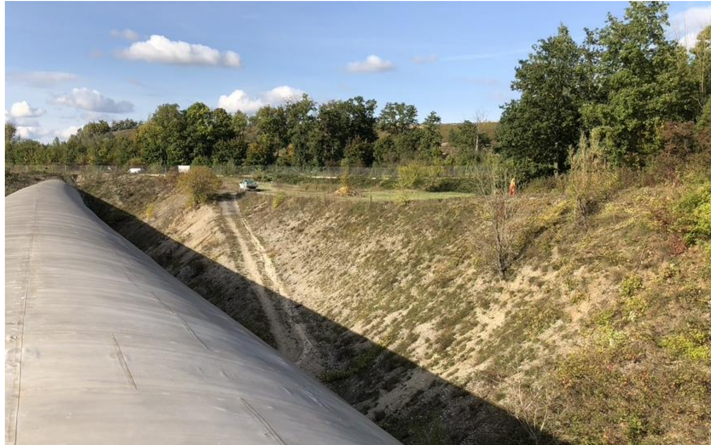
Adlertunnel Pratteln (Foto: Philipp Götsch)
